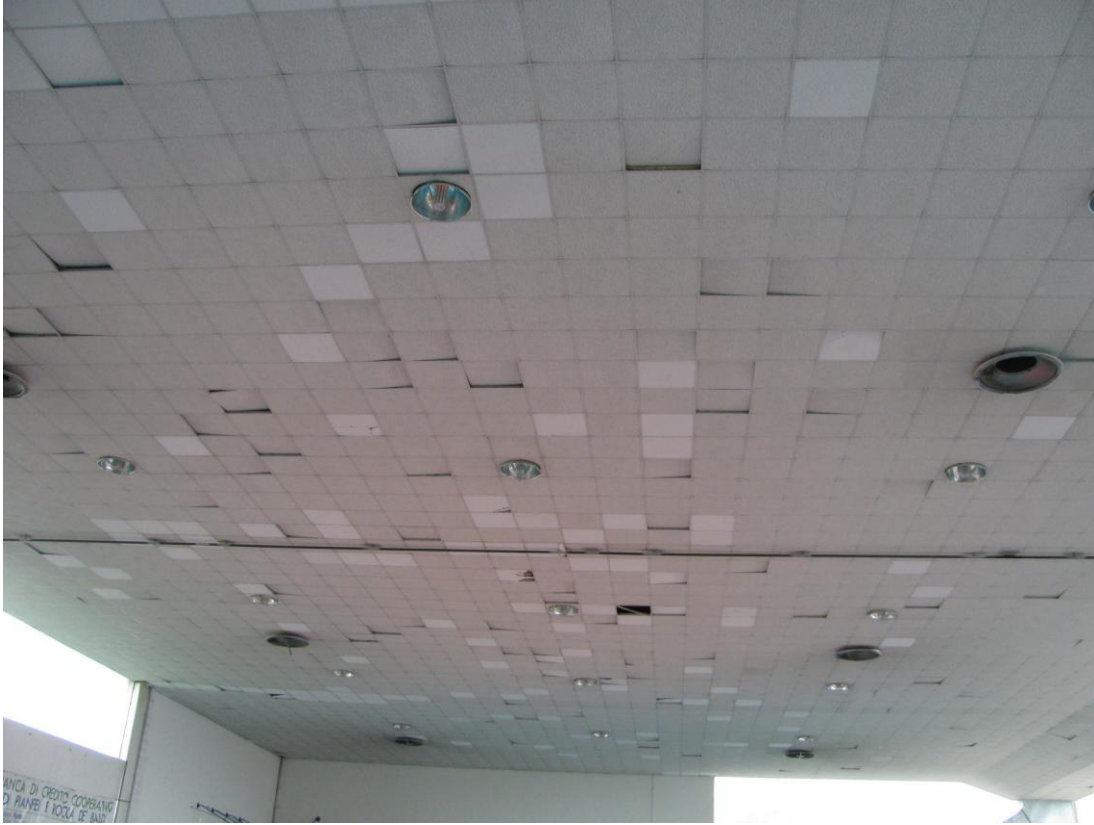
8) Condizione di degrado della controsoffittatura
